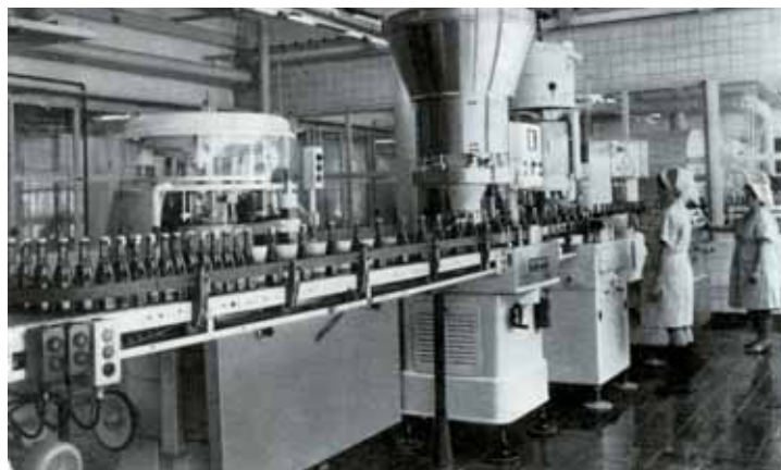
Abfülllinie mit erstmals voll automatisiertem Verschließen, Verdrahten (bei manuellem Aufsetzen der Bügel), Stanniolieren und Etikettieren, 1969
