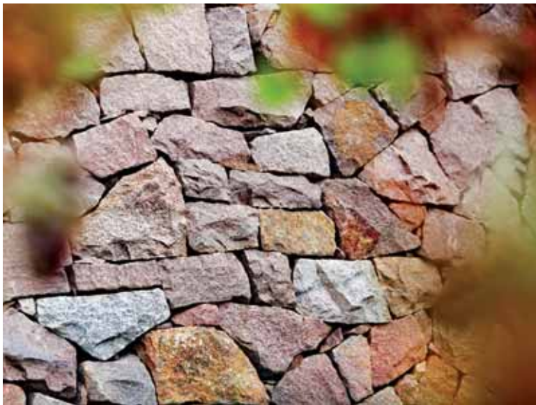
Viele erneuerte Trockenmauern prägen das Bild der sächsischen Steillagen.
