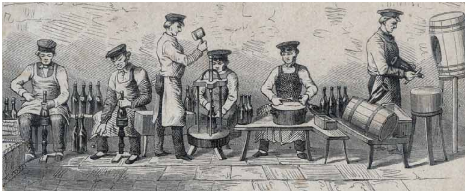
Schaumweinfabrikation um 1860 in der Niederlößnitz: Pfropfen und Verpichen der Flaschen Unten: Vignette aus der Bussard-Festschrift, 1911
