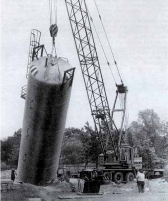
Aufstellung des ersten Gärreaktors in Freibauweise mit einem Volumen von 110.000 Litern, 1978
